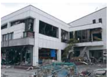
2階まで浸水した津波直後の本店。今は仮本店で営業している
